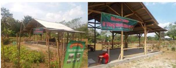
Gambar 3. Proses Pembangunan Pusat Kegiatan Kawasan Taman Brajan (Sumber : Dokumentasi Peneliti, 2019)
