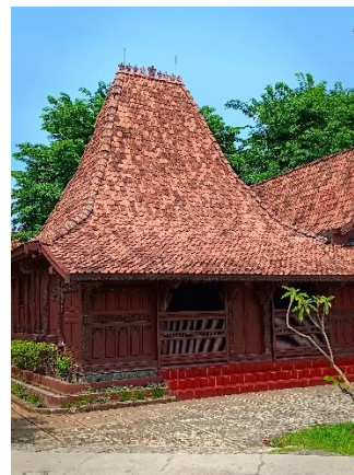
Gambar 2. Rumah tradisional Kudus "joglo pencu" yang dilengkapi dengan tangga berundak dan atap yang dibuat lebih panjang dengan seni hias wuwungan gerabah yang gemerlap.
