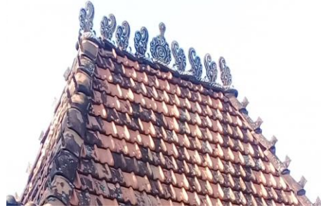
Gambar 1. Seni Hias wuwungan pada atap rumah tradisional Kudus “ joglo pencu ” yang juga dibuat krawangan atau tembus pandang dengan teknik inlay menggunakan pecahan beling pada bodi gerabah yang menjadi salah satu ciri khas seni hias Kudus (pesisiran).
