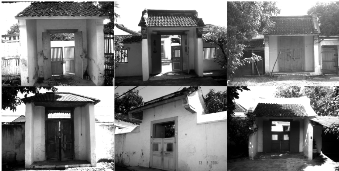
Gb.8. Pintu gerbang yang memiliki dua pasang pintu
