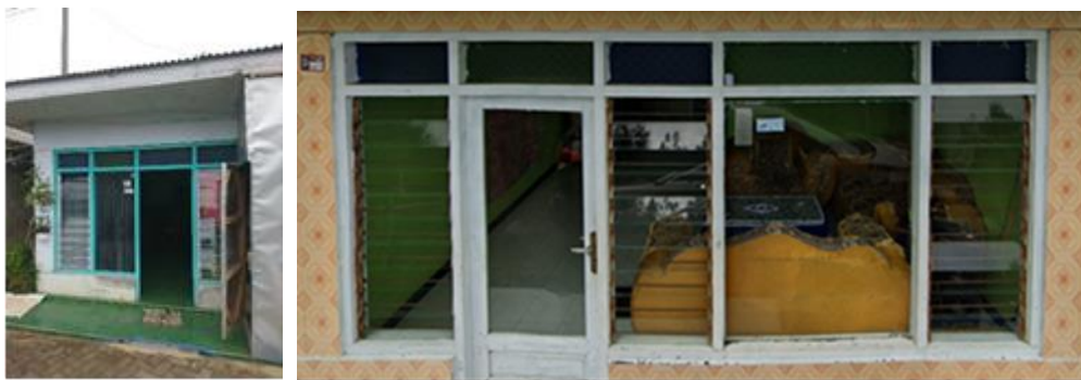
Gambar 5. Teras Rumah Tengger (kiri), Ventilasi Rumah Tengger (kanan) (Sumber: penulis, 2023)
