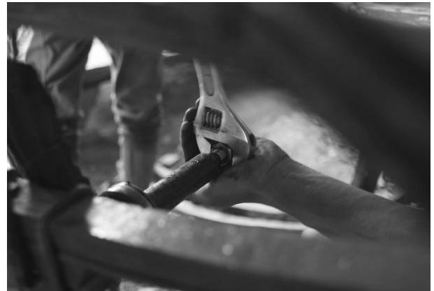
Frame 3. Pemasangan baut.
